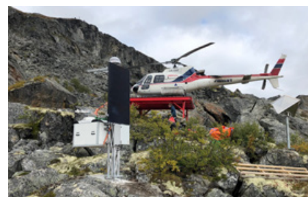
Nymontert GPS-antenne ved Tussafoten, med helikopter i bakkant.
