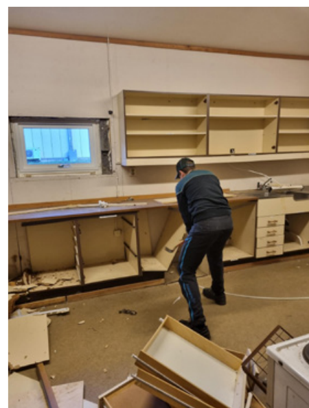
Riving av gamle kjøkkenet.
