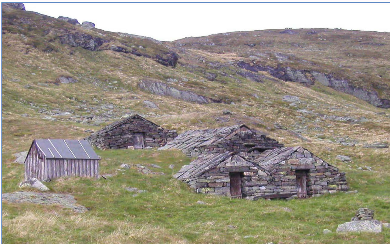
Stølen Peisabotn i Ullensvang, eit av få intakte gamle stølsmiljø utan nyare bygg. Foto: Trond Aalstad
