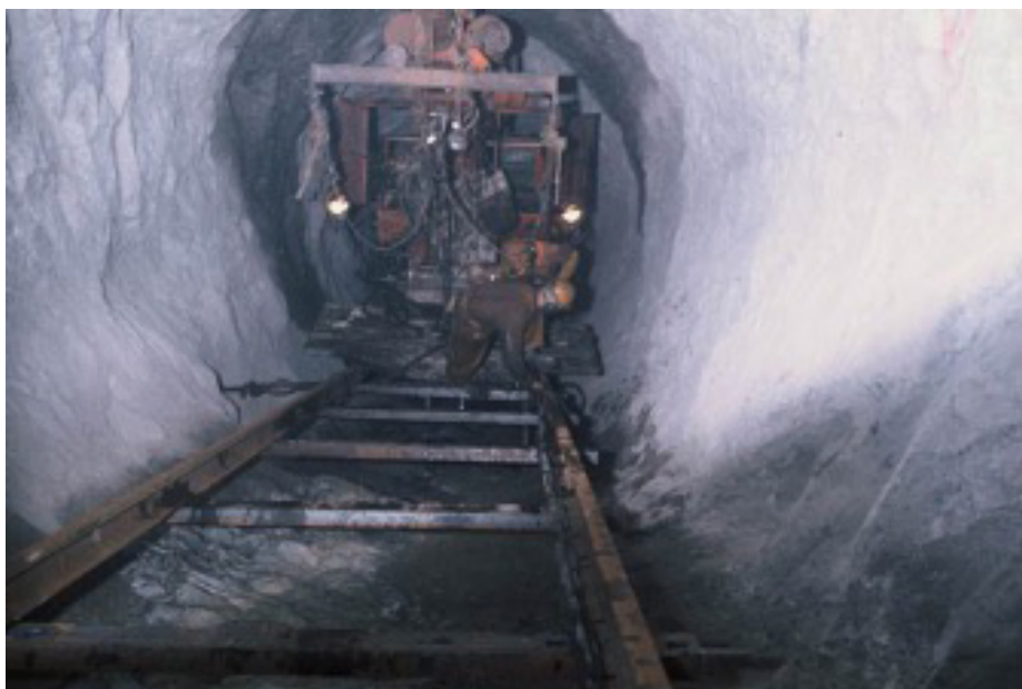
Skinnelegging sjakt februar 1977.
