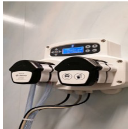
Automatisk kjemikaliedosering.
