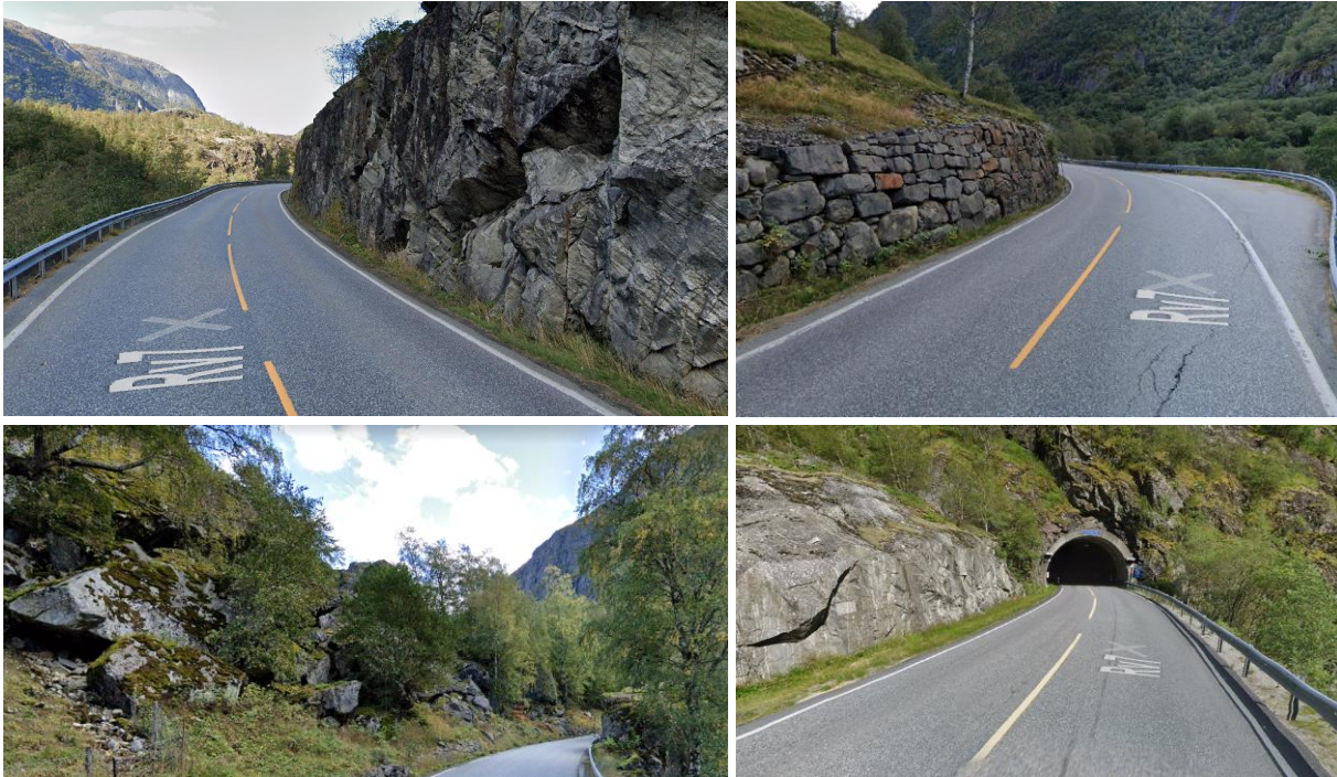
Figur 13 Oppe t.v. eksempelstrekning behov for veistengning pga. sprengning eller graving i vei. Oppe t.h. arbeid med riving og reetablering av steinmur. Nede t.v. rasfare ved etablering av grøft. Nede til t.h. omfattende sprengning på vestre side av veien for å etablere dyp borgrop for å bor under Kvernhusaugtunnelens øvre innløp og ut ved tunnelens nede utløp. Alle foto fra google street view.
