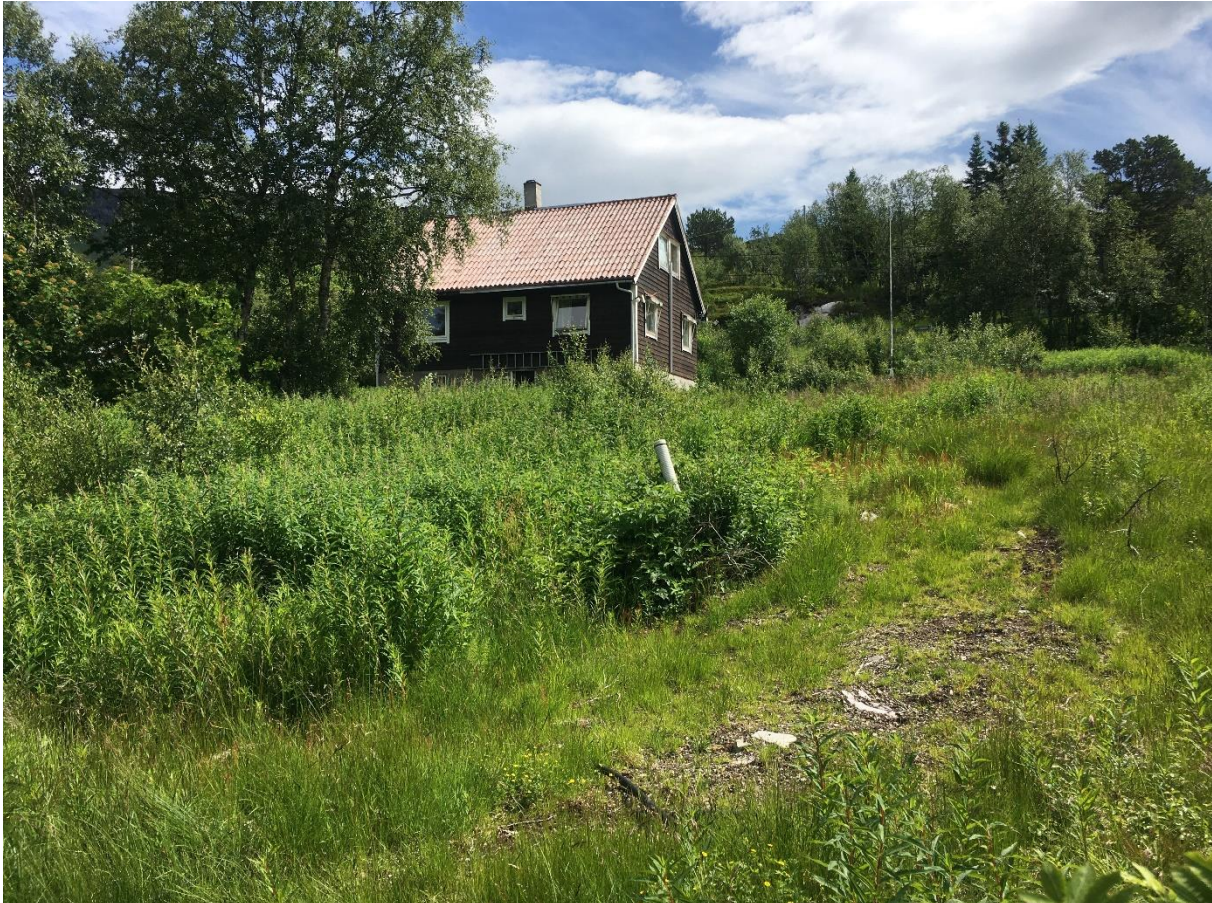
Figur 27 Hytte/hus som må rives på tomten. Foto er tatt omtrent der hvor bygget er plassert på forrige figur. Terreng må heves opp til omtrent samme nivå som huset/hytten. Bjoreio er bak fotografen. Svart pil på forrige figur viser fotoretning.
