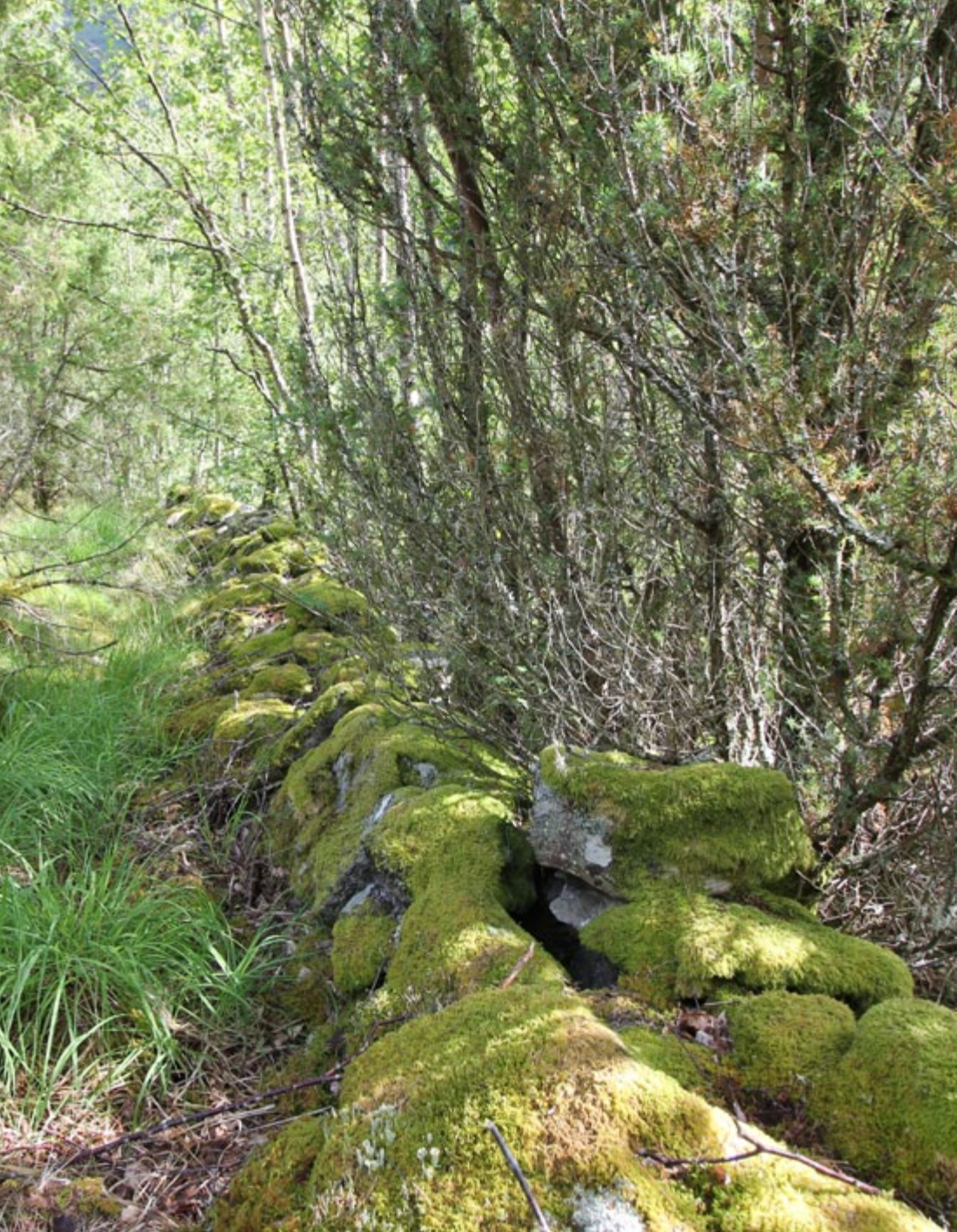
Steinmur i forsvarsanlegget på Steinberg.
