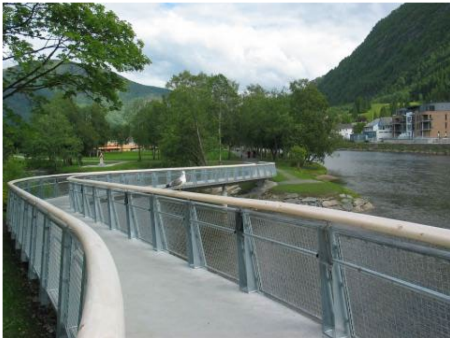
Bankbrua i Førde i Sunnfjord kommune
